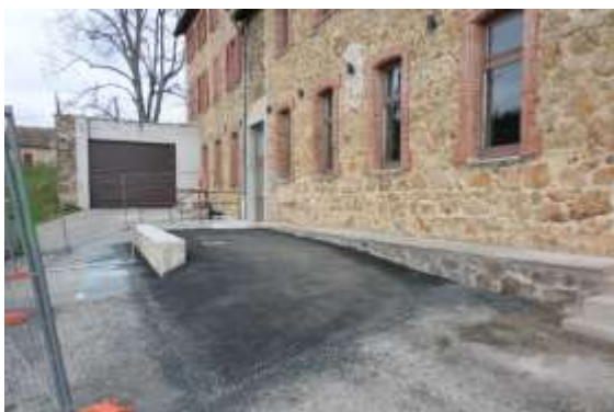
Aménagement extérieur pour personnes à mobilité réduite
