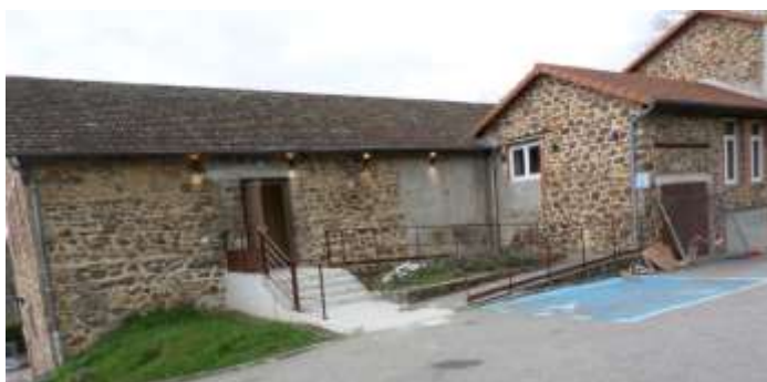
Aménagement extérieur pour personnes à mobilité réduite
